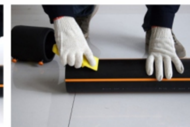
刮除管材表面氧化层，刮削深度0.1~0.2mm左右；
