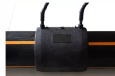
将刮削端插入至管件限位挡台，用固定夹具将两端的管材固定；
