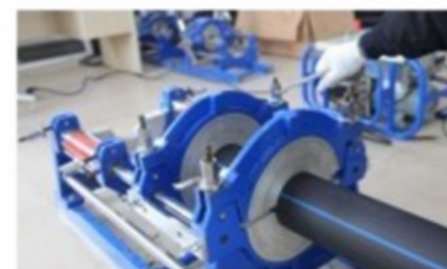
检查管材清理端面并紧固管材
