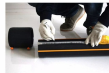
用记号笔标记刮削区域，刮削长度应在插入深度长10mm以上；
